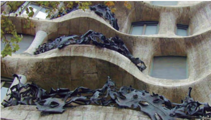
Balcons de la Casa Milà (realitzats amb ferralla de desballestament) 54
