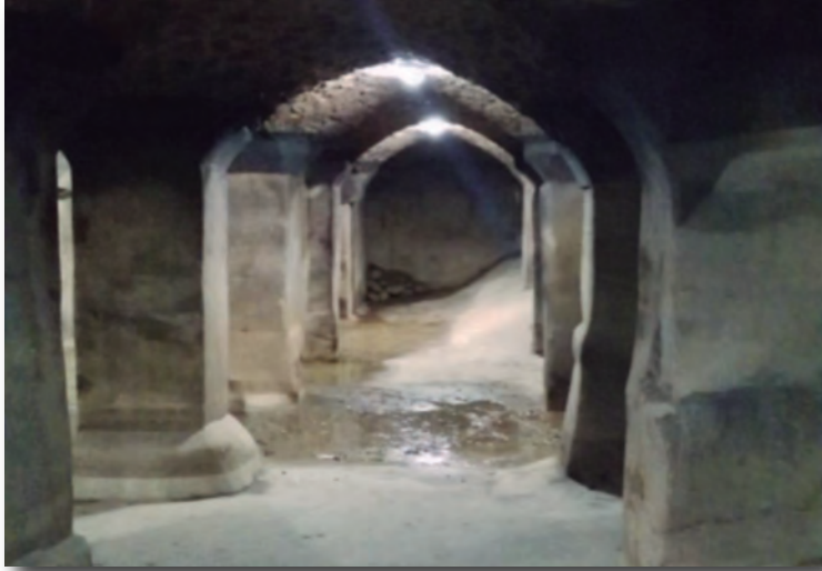
Cisterna inferior del Parc Güell 61
