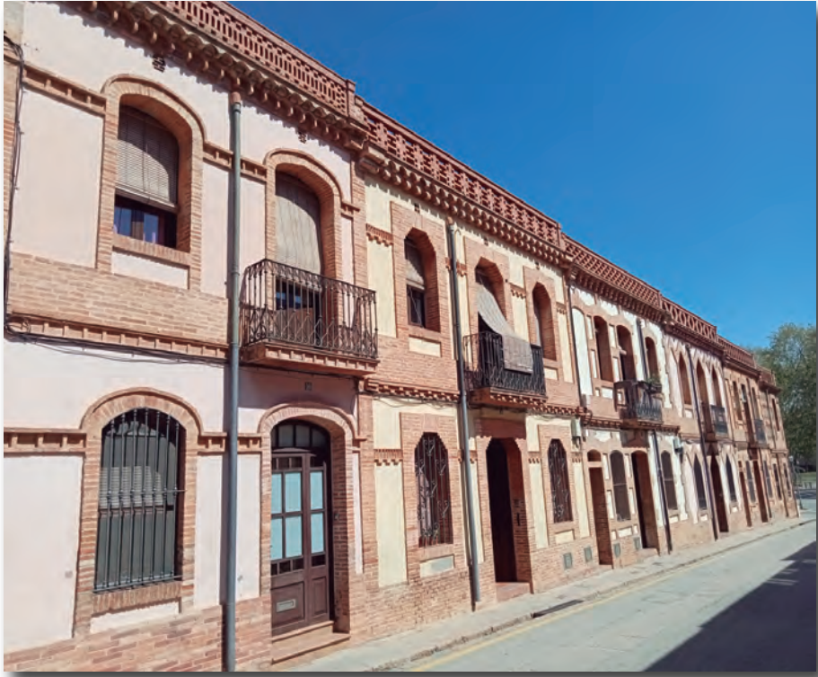
Carrer de Reixach a la Colònia Güell amb les cases dels treballadors]
